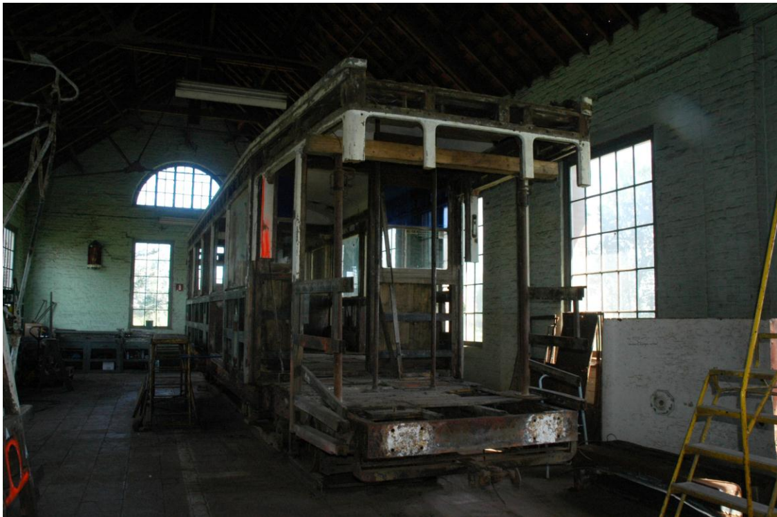
Situatie juli 2007 : houtwerk van de kop is gedemonteerd
