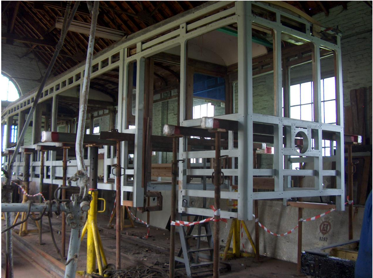
De rijtuigkast is gescheiden van het chassis en steunt enkel nog op schragen ; een ideale positie om de vloer te vernieuwen en onderaan te behandelen.
