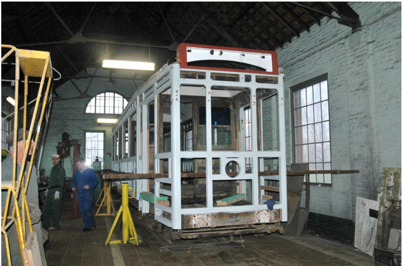
En in januari 2008 : het houtwerk is volledig hersteld en in de primer gezet, klaar om kast en chassis van elkaar te scheiden. De gerenoveerde filmkasten zijn eveneens geplaatst.
